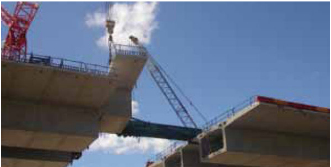
Kuva 6. Rakenteilla oleva Gateway-silta Australiassa / 1 /.
