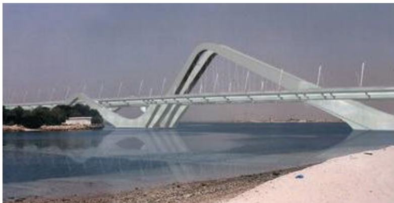
Kuva 2. Sheik Zayed –silta Abu Dhabista. Silta valmistuu vuonna 2011.
