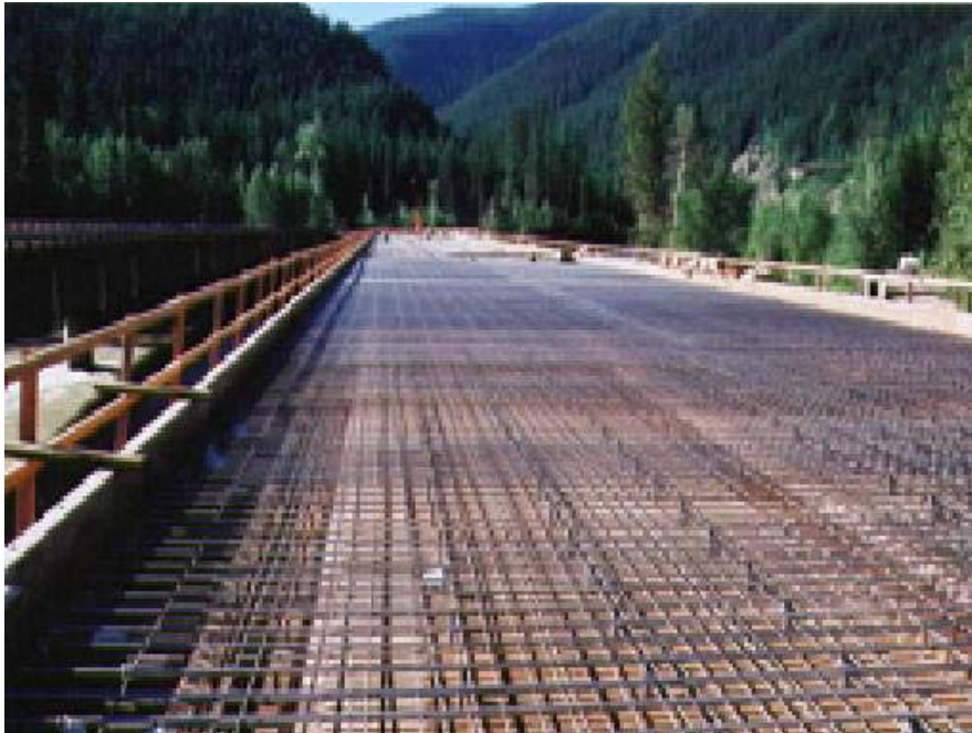
Kuva 5. US Route 2 –maantiesilta käyttäen ruostumatonta terästä raudoiteissa / 10 / Australiassa rakennetaan Gateway –siltaa Brisbaneen, kuva 6. Se valmistuu vuonna 2011 ja siinä käytetään pioneerikohteena ruostumatonta terästä Duplex LDX 2101 / 11 / . Kysymyksessä on moottoritien toisen ajoradan silta.
